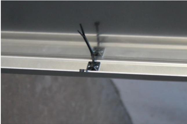
Ziehen Sie je einen Kabelbinder durch die Lasche der selbstklebenden Kabelhalterungen.
